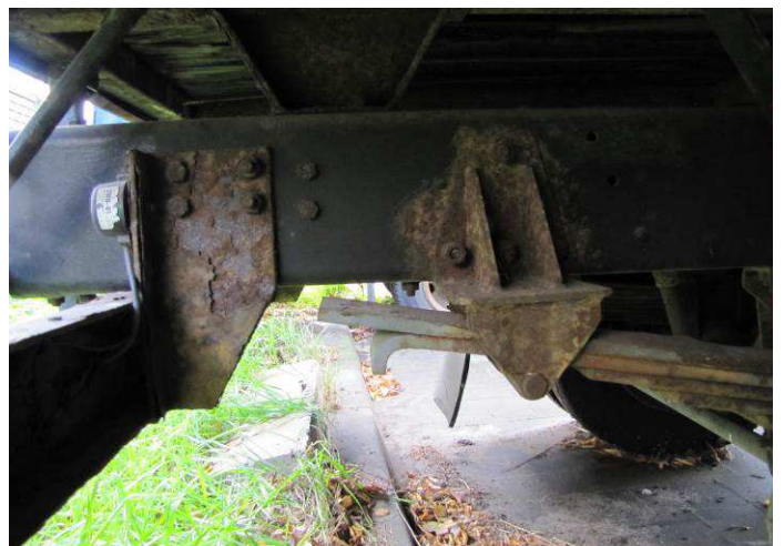
skorodowane elementy mocowania resora do ramy
